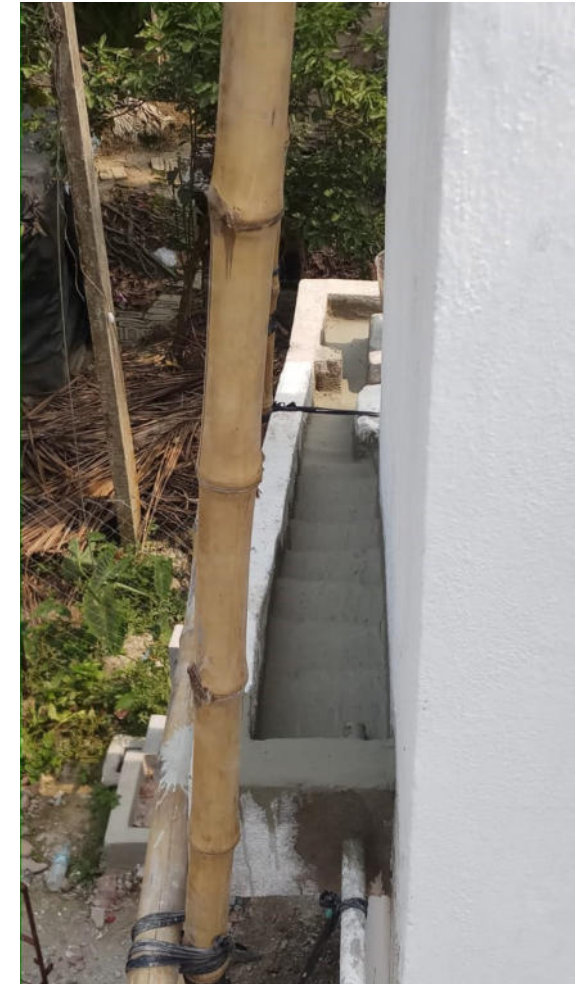
Bau und Anbringung der Fließkontrollvorrichtungen und Sieben des Filtersands
