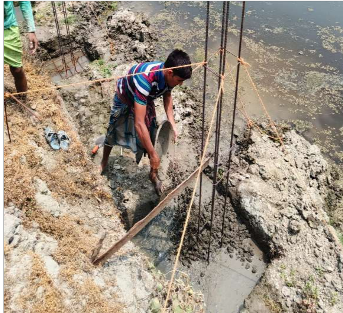
Fundamentarbeiten für die Schutzmauer
