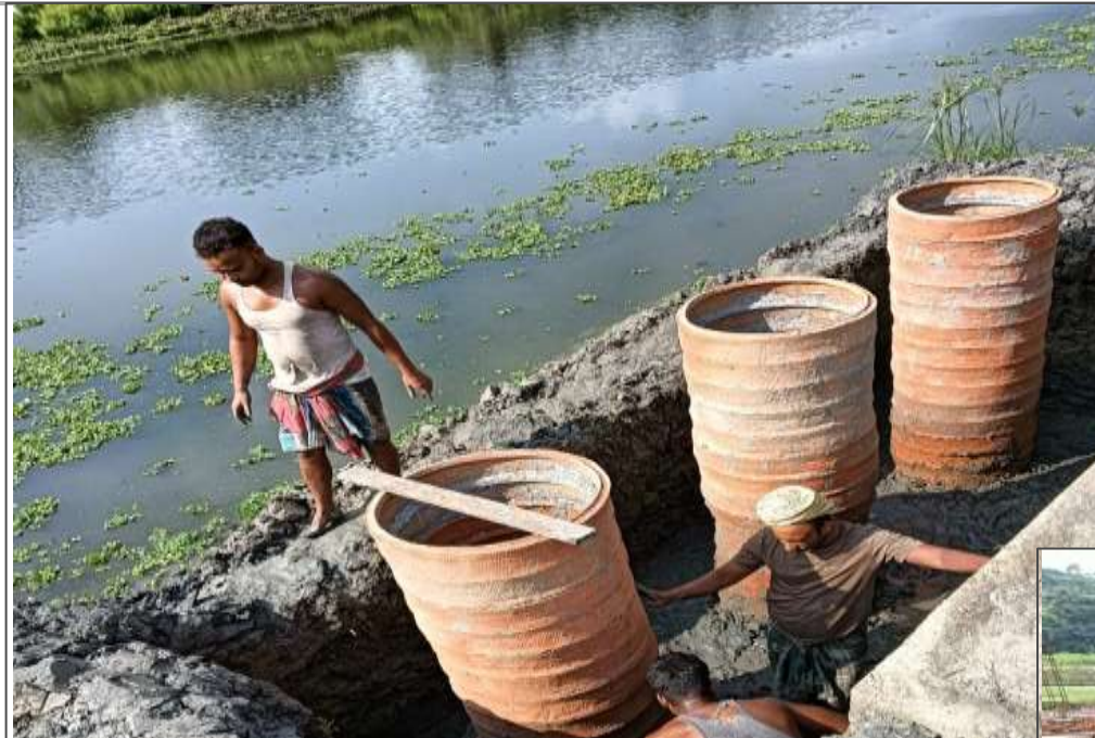
Installation der Entnahmebrunnen am Flussufer
