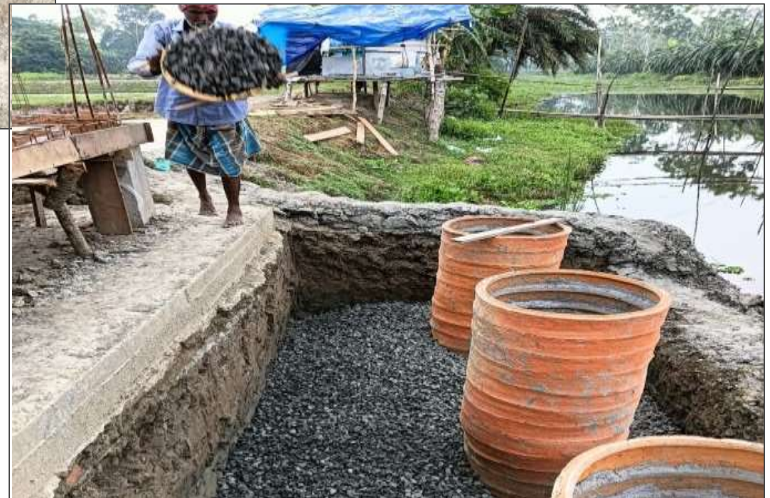
Aufschüttung von Kieskörpern um die Einlaufbauwerke
