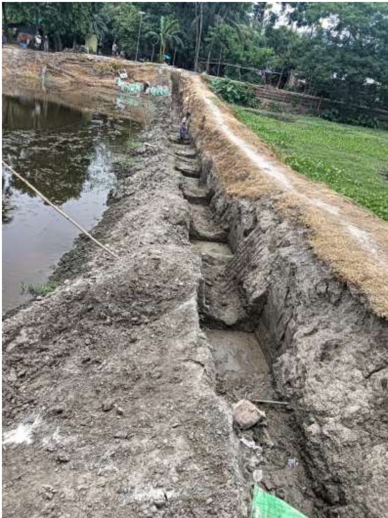
Aushub für die Schutzmauer an einer längeren Seite des Teichufers
