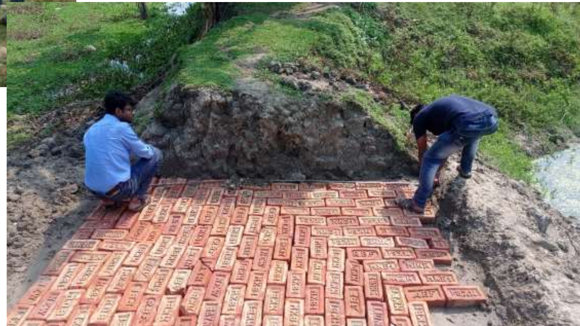
Überprüfung der Verschmutzung der Ziegel
