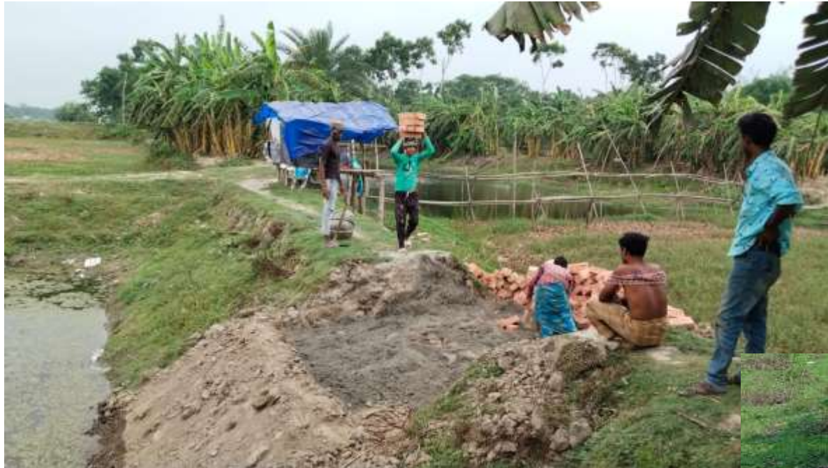
Aushub und Sandauffüllung
